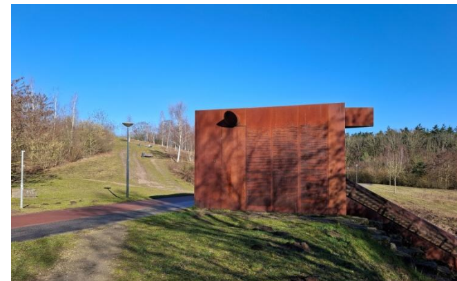
Het gemaal (IB).
