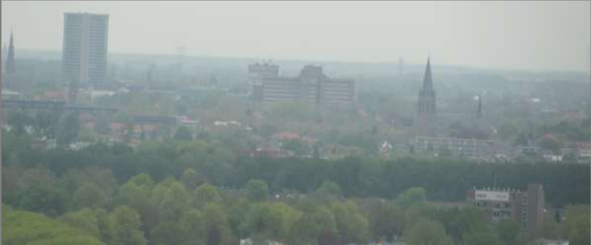
Eindhoven: gebouw Technische Dienst, Vestedatoren en Porthos Tower liggen heel dichtbij.
